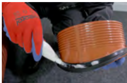
6. Podmazivanje gumice na telu saga
