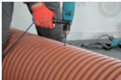
3. Bušenje rupe za vodiču krunaste testere
