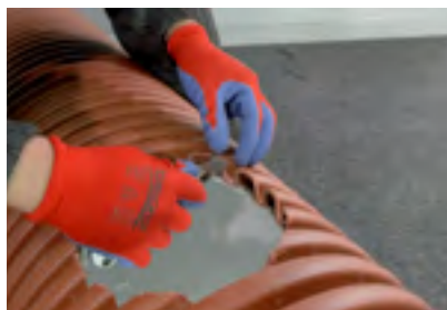
5. Obrada rupe za sag i čišćenje opiljaka
