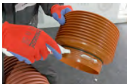
10. Podmazivanje odgovarajućeg priključka za sag
