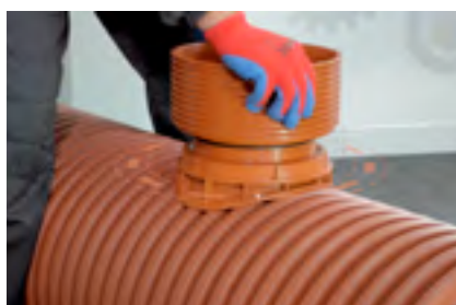
11. Postavljanje odabranog priključka
