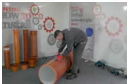
2. Odrješivanje pozicije za montažu
