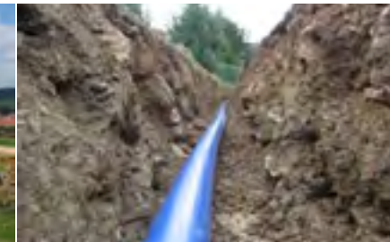
postavljanje bez peščane posteljice
